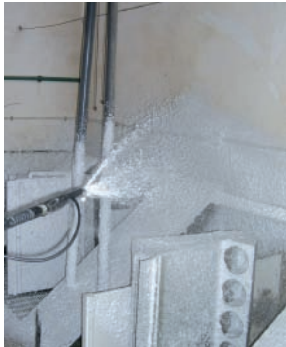
Figura 1.- Tareas de limpieza y desinfección en la nave de transición.
