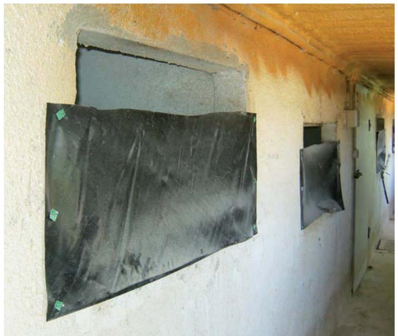
**Foto 2.-** Reducción de la apertura de las ventanas que comunicaban el pasillo de manejo con cada módulo.
